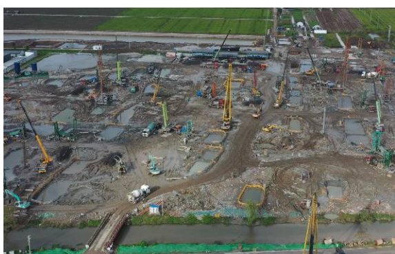
桩基及泥浆固化
