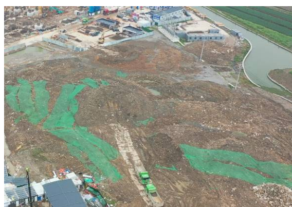
临时堆土场苫盖
