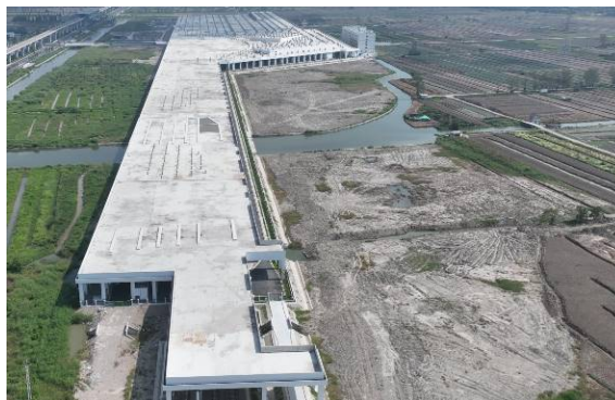
原临时堆土场场地平整
