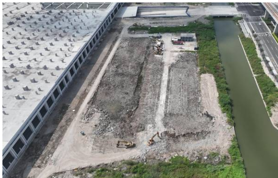
施工工区场地平整
