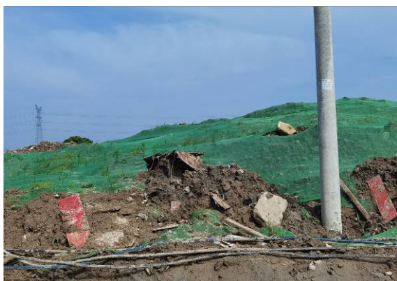
临时堆土场绿化及苫盖
